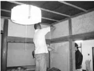
写真 4-21 和室の漆喰の剥離作業
