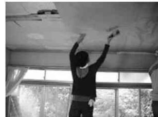
写真 4-17 タッカーを用いて天井にクラフト紙を張る
