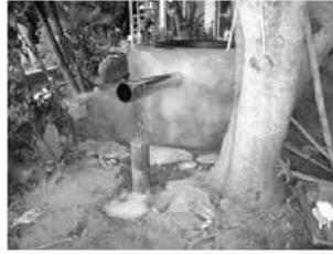
写真4-14 竹を利用した煙突支持台
