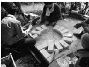
写真4-5 基礎コンクリートの上で耐火煉瓦の配置を検討
