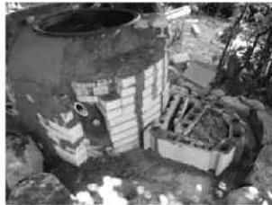
写真4-11 コンクリートブロックとガラで階段の原型を作る
