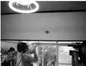
写真 4-15 漆喰と下地の剥離作業
