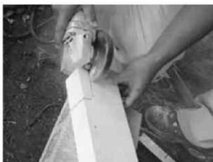
写真4-6 グラインダーによる耐火煉瓦整形
