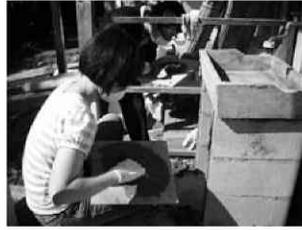
写真 4-23 外部流しのブロック積み
