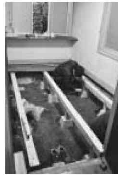
写真12 東と大引きの設置
