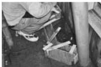
写真24 便所くみ取り口のモルタル工事
