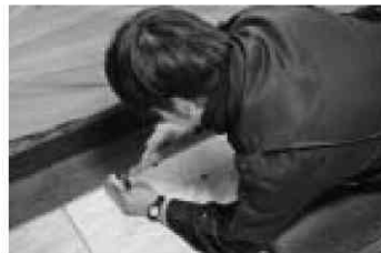
写真16 フローリング材の取り付け
