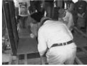
写真30 ベニヤの下張り
