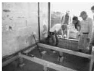
写真28 大引の取り付け
