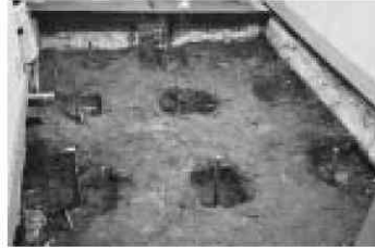
写真8 地面の根切り
