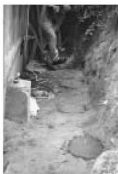
写真21 崖下に打たれた捨てコン
