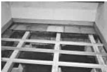
写真13 根太の設置
