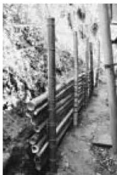
写真23 完成した土砂止め用の竹柵
