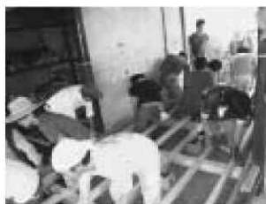
写真29 根太の取り付け
