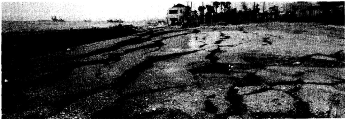
写真-23 護岸背面の地割れ（ニ地）
