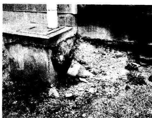
写真-8 O市埋立地の地盤沈下による配水管の抜け落ち
