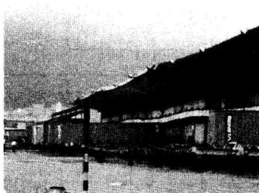
写真-5 K市埋立地の建物の不同沈下
