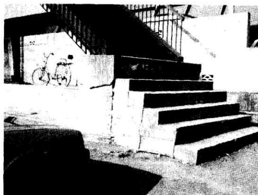
写真-6 K市埋立地の地盤沈下による階段の継足し
