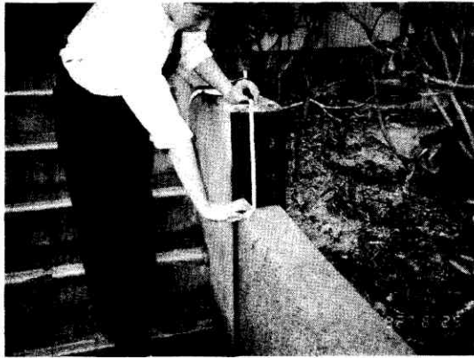
写真-11 出入口部の段差 (C地、地震前：1984.11.7)
