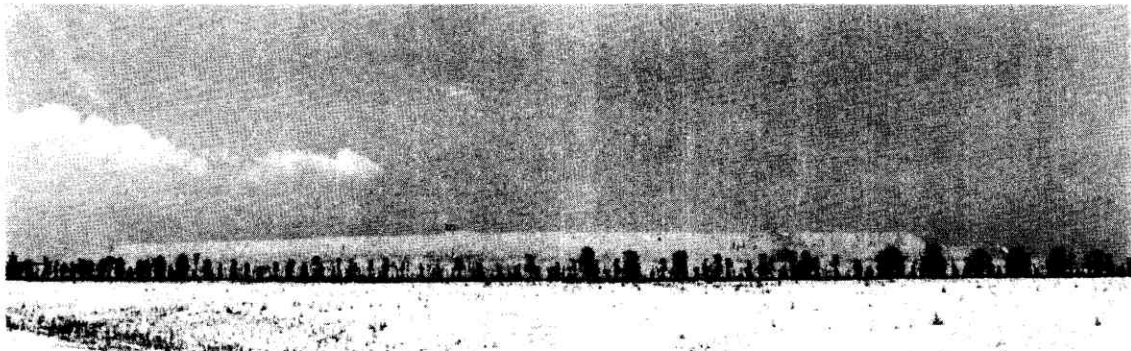
写真-10 高さ10mのプレロード (C地:1975)
