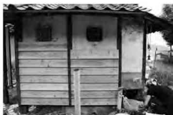
写真14 杉板の下見張り工事
