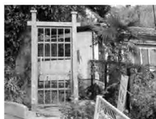
写真4 完成した裏門
