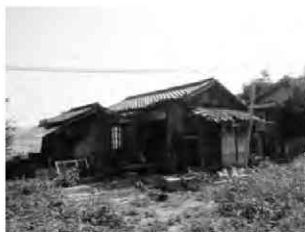
写真5 アクアの森に残された空き家（北面）
