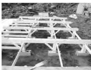
写真33 方杖と根がらみによる補強
