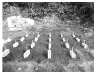
写真28 土を戻したステージ基礎の並び
