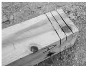
写真30 束に電動丸ノコで深さ30mmの刻みを入れた部分
