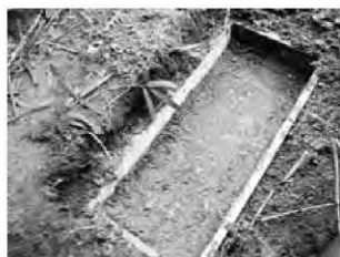
写真25 捨てコン用の木枠。底に土を入れ突き固めた
