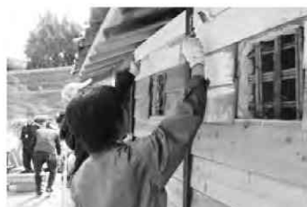
写真15 下見張りの壁の塗装
