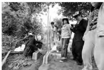
写真16 屋外キッチンのブロック積み
