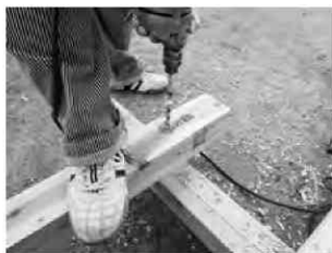
写真31 電動ドリルを使用した大引きの ホゾ穴加工
