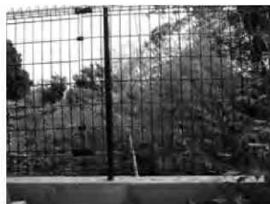
写真2 ネットフェンスの接続箇所
