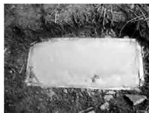
写真26 型枠天端まで捨てコンを打つ
