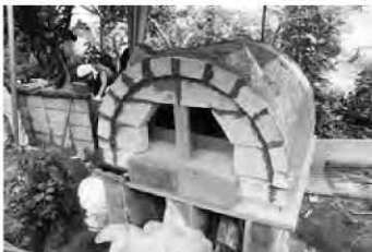
写真22 耐火煉瓦の釜をアルミホイルとメタルラスで包む
