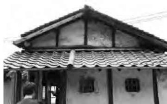
写真13 完成した便所の屋根。左と右の瓦の大きさが違うため、境目に棟瓦を乗せた
