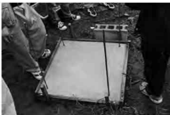
写真20 ピザ釜の基礎作成
