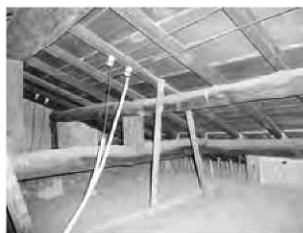
写真8 家屋の天井裏。屋根の雨漏りは見られなかった
