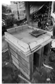
写真21 ピザ釜のブロック上に設置された天板
