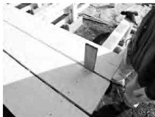
写真35 床板の取り付け
