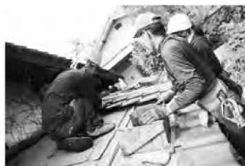
写真12 野地板にアスファルトルーフィングを敷き、タッカーで止める
