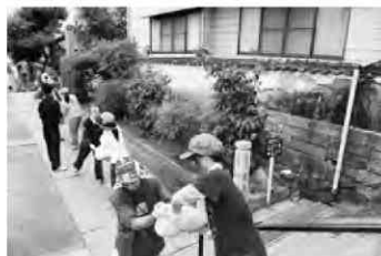
写真10 人の手渡しによる資材搬入の様子
