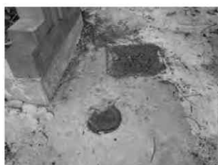
写真3 森の家裏門地面のコンクリート舗装 （奥が水量計、手前が止水栓）
