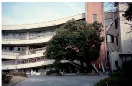
▲ 阪神・淡路大震災で倒壊した夙川キャンパス
