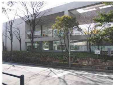
（写真6） 大手前アートセンター
