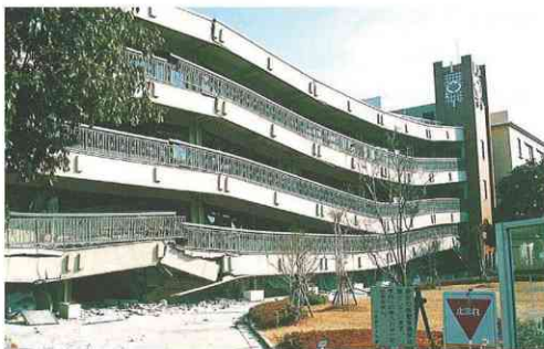
震災で被災した旧本館 平成7（1995）年
