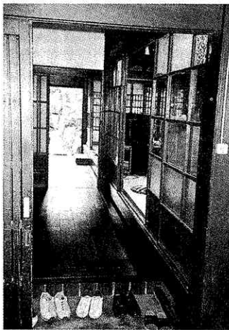
写真27 (新) 内玄関より食堂を見る
