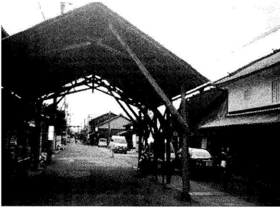
写真3-1 道路上に現存する市の上屋
